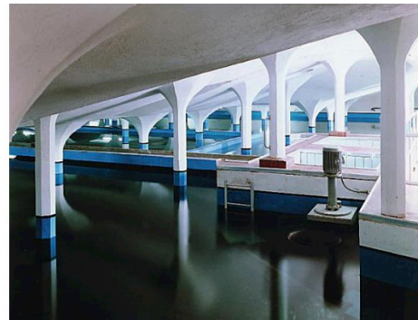
Die bereits abgebrochene Filterhalle von Robert Maillart, 1912
