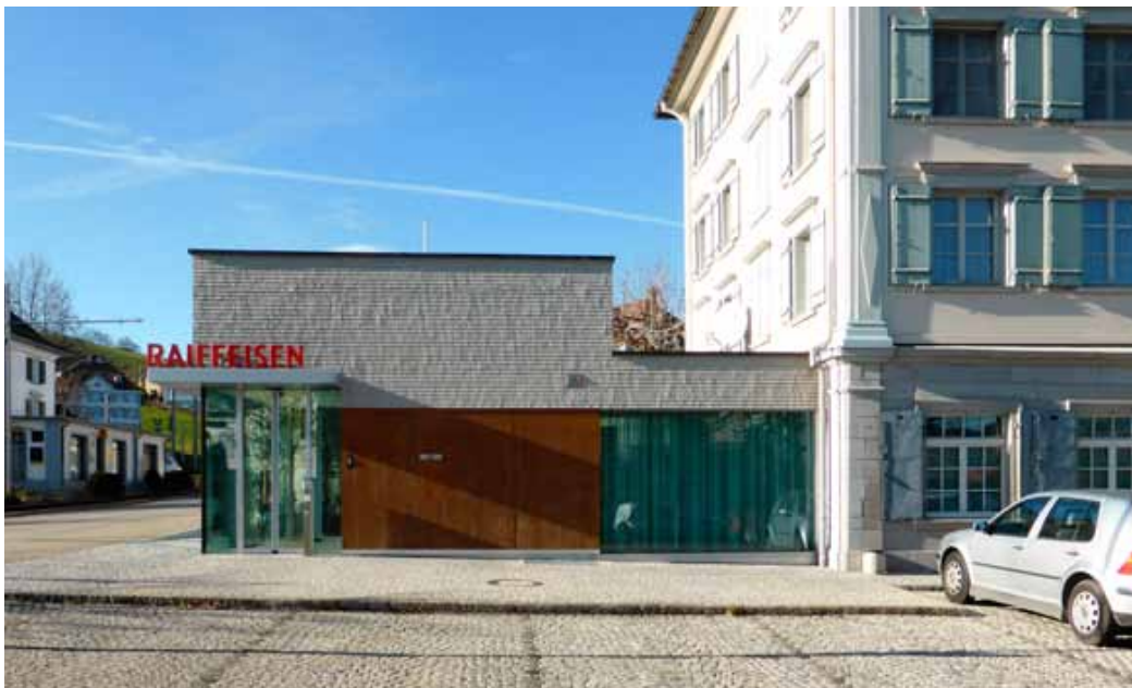
Abb. 38 Abgesetzter Anbau der Raiffeisenbank in Speicher. Die verbindenden Elemente sind hier die Dachkonturen. Die Schindelfassade wirkt zum Haupt- bau hin eher als fremd. Speicher.
