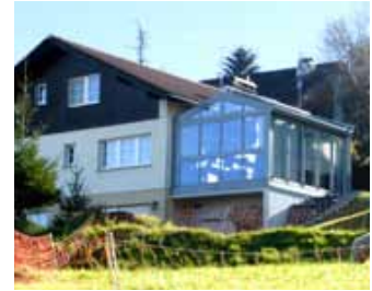
Abb. 73 Die Verwendung eines Wintergartens mit Schleppdach hätte hier für eine bessere, harmonischere Lösung gesorgt. Grub.
