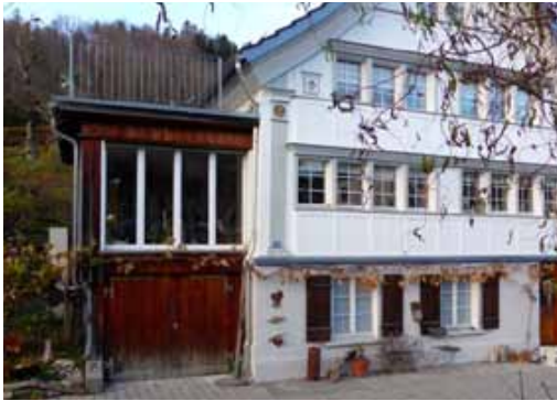
Abb. 55 Bei diesem Flachdach Anbau ist die Verwandtschaft zum Stöcklokal gut ablesbar. Die neuen Fenster sind gut auf die Konturen des Hauptbaus abgestimmt. Sehr schön die Terrasse auf dem Dach, der Zugang findet über eine rückseitige Treppe statt. Bühler.
