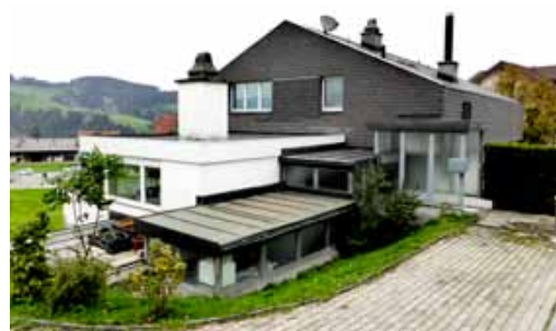
Abb. 52 «Wildwuchs» zeigt sich auch bei neueren Gebäuden. Weiterbauen ist nicht nur ein Thema bei traditionellen Häusern. Hundwil.
