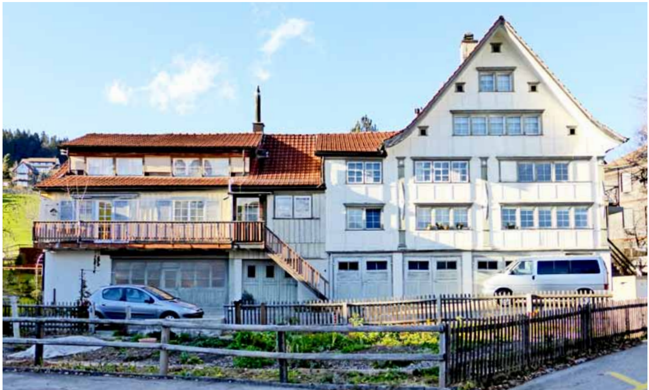
Abb. 50 Ein gutes Beispiel für Wildwuchs. Das Gebäude erweitert sich schier unendlich zur linken Seite hin. Sicherlich vier Erweiterungen haben hier stattgefunden. Eine sehr freie, aber sorgfältige Art des Weiterbauens, das Neue ordnet sich dem Hauptbau klar unter. Speicher.
