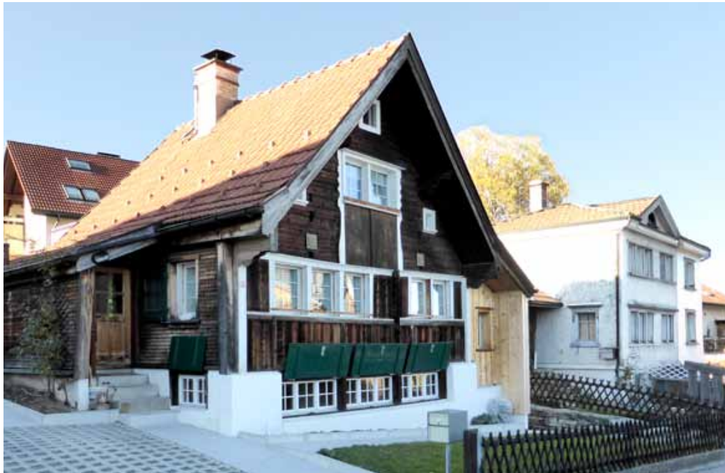
Abb. 39 Weberhäuschen mit beidseitig unter dem Dach hervorgezogenen Anbauten. Beides sind, eigenartigerweise, Hauseingänge. Schön zu sehen, die Klappläden für den Webkeller.
