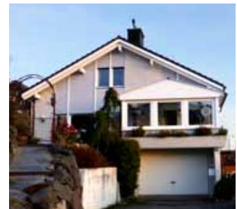
Abb. 78 Durch die Kopie der Dachform und der Materialisierung integriert sich der Wintergarten sehr gut. Rehetobel.
