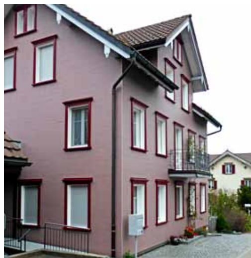
Abb. 92 Beispiel einer energetischen Sanierung bei der wohl die Klappläden durch Rollläden ersetzt wurden. Es sind tiefe Laibungen entstanden, die durch die eigentlich typische, weisse Farbe noch betont werden. Hundwil.
