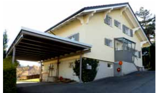
Abb. 34 Standardisierter Autounterstand und Windfang aus Metall an einem Haus aus den ca. 1950er Jahren. Heiden.
