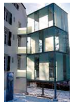
Abb. 80 Freistehender Balkon- Turm. Umbau, MFH, Emil Klöti-Strasse 31 8406 Winterthur, 2006 http://www.hannes-moos.ch Architektur Büro Hannes Moos, Winterthur
