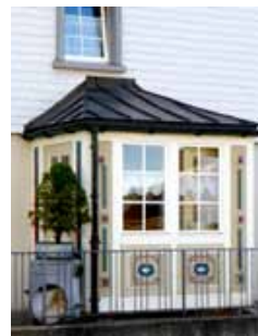
Abb. 35 Vierseitig geschlossener Windfang. Speicher
