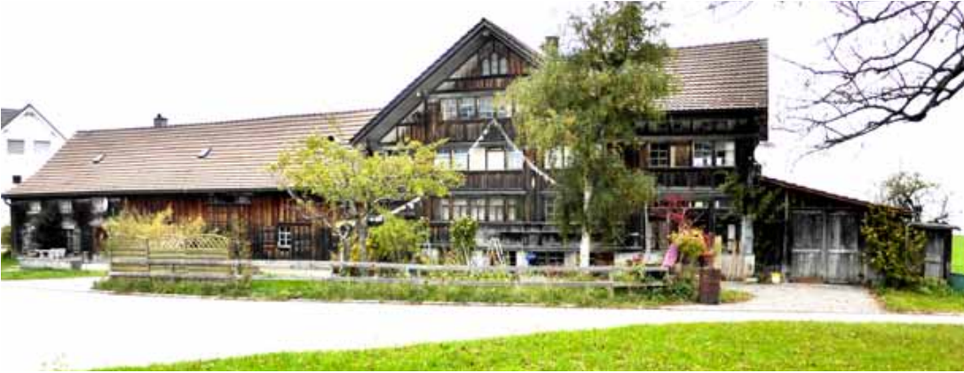
Abb. 51 Grossformat, bestehend aus: Bauernhaus mit Stall und Webkeller, rechts erweitert mit Stöcklokal und zwei Schlüpfen und links, anschliessend an den Stall, vermutlich eine Wohnung für den Knecht. Stein.
