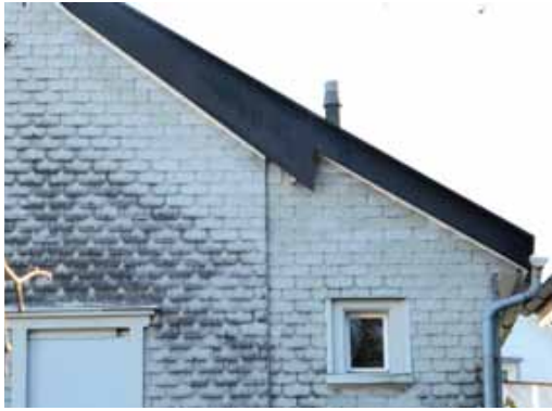
Abb. 98 Kaum zu sehen, aber ein Indiz für einen Anbau. Der unterbrochene Dachübergang zum neuen Teil. Grub.
