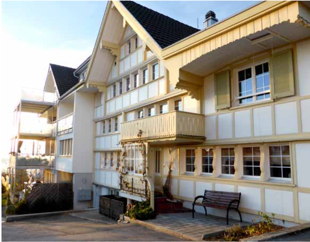
Abb. 67& 68 Mit dem Anbau im Bild-Vordergrund wurde mit einem Windfang beim Eingang auch ein Balkon geschaffen. In neuerer Zeit erfolgte ein grosser Anbau, der das Gebäudevolumen verdoppelte. Die Balkone am neuen Teil entsprechen den heutigen «Standards» und fügen sich in Machart und Proportion nicht gleich dezent in das Ensemble ein, wie jener über dem Windfang. Positiv zu erwähnen ist die Farbgebung, sie hilft bei der Integration. Rehetobel.
