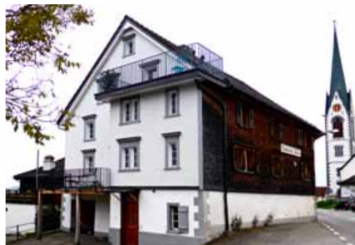
Abb. 70 Bescheiden ausgeführte Balkonlösungen, die auf vorgegebenen Grössen wie Dachvorsprüngen oder Hausbreiten beruhen. Hundwil.
