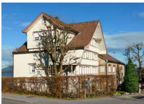
Abb. 60 Die Gestalt dieses Dachaufbaus (Hut) erinnert an ein kleines Appenzellerhaus, wie wenn man eine «Kleine Kopie» auf das Dach gesetzt hätte. Die Fassade mit dem Aufbau, wird fast zum zweiten Gesicht, insbesondere da sie zur Hauptstrasse ausgerichtet ist. Speicher.
