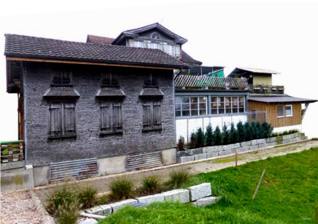
Abb. 54 Das Haupthaus wird in der Rückansicht buchstäblich überwuchert. Das ständige Anpassen des Gebäudes an die neuen Ansprüche der wohl wechselnden Besitzer lässt sich schön ablesen. Freizeit und Arbeit wird hier vereint. Wohnen, Werkstatt, Dachgarten, Bocciaabahn. Hundwil.
