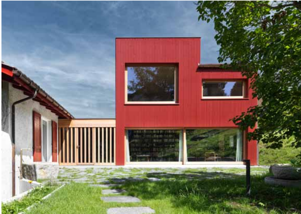
Abb. 37 Anbau von 2013, der sich vom Hauptbau absetzt und so Raum für stilistische Freiheit gewinnt. Trotz- dem übernimmt er Farben und Proportionen vom Hauptbau. Herisau.
