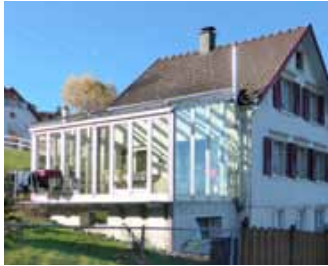
Abb. 71 Bis auf das Schleppdach wurden keine Anpassungsversuche unternommen. Heiden.
