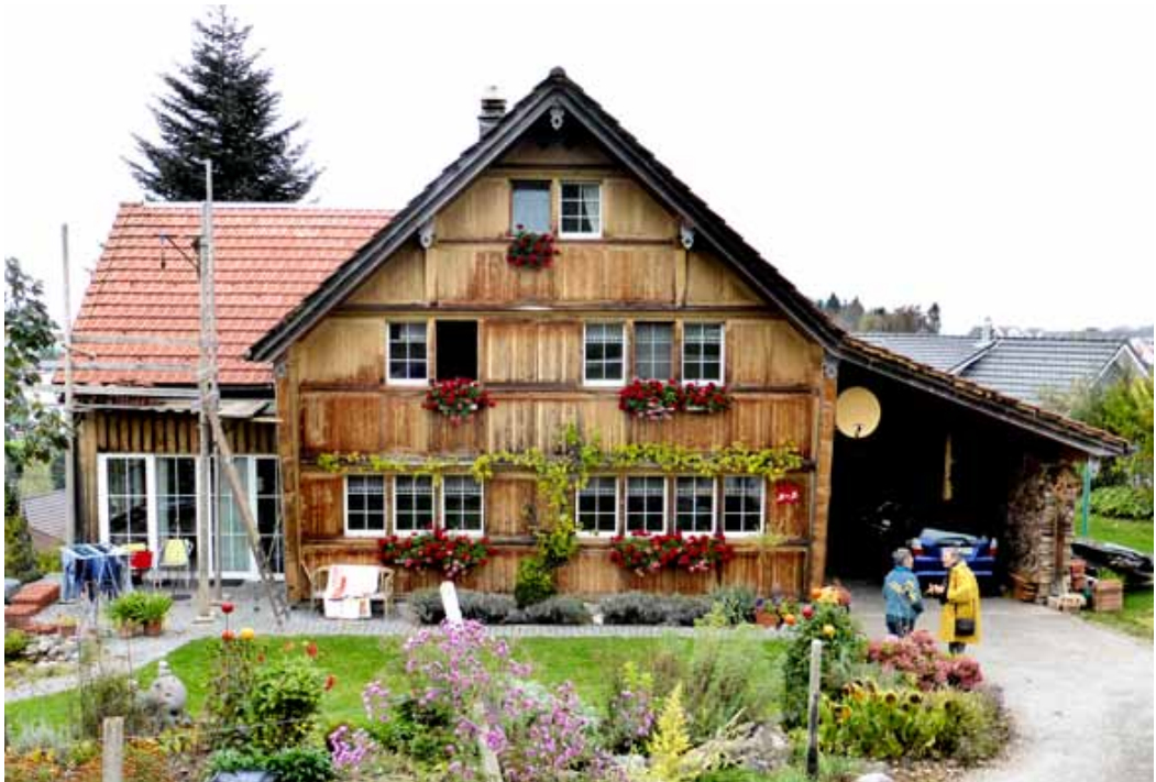
Abb. 104 Dieses Einfamilienhaus wurde mit Unterstand und Wintergraten in den 1980er Jahren von seinen Besitzern erbaut. Durch die vielen Details am und um das Haus beginnt es zu leben. Das improvisierte Baugerüst fällt kaum auf. An der Fassade auf dem obigen Bild, wäre das Gestänge eine starke Irritation. Detailfreudigkeit schafft also auch Spielraum. Stein.
