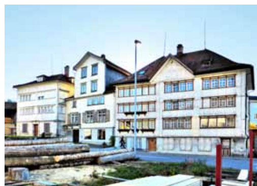
Abb. 61 Zum einen sieht man in dieser Häuserzeile den sehr markanten Aufbau, der die Merkmale eines Stöcklokals hat, nur wurde er auf einen Zwischenbau gesetzt. Auch das rechte Haus muss einmal stark erweitert worden sein, man beachte das nicht mittige Dach. Trotz den vielen Typen und Elementen wirkt der Bau, wohl durch die Konturierung, recht einheitlich. Heiden.
