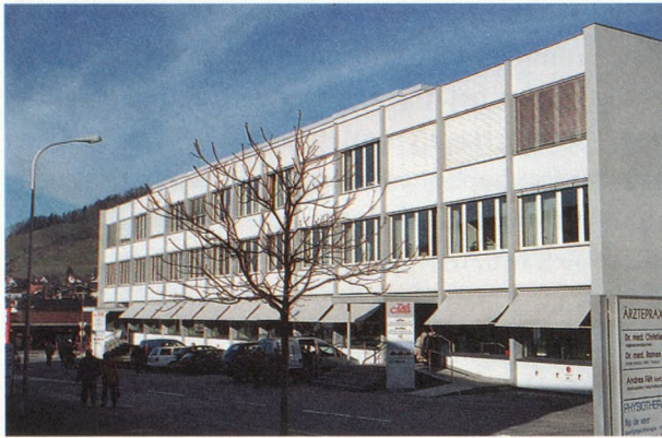
Geschäftshaus der Albin Breiten- moser AG an der Zielstrasse in Appenzell (2007).
