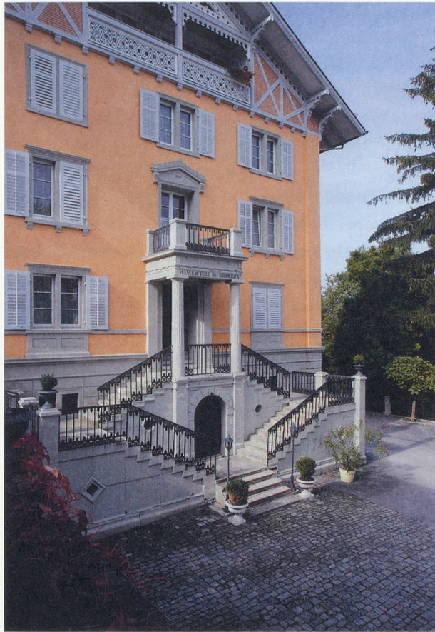
Hauptfront der «Manufacture de broderies» von J. Georg Euler- Bänziger in Lutzen- berg, erbaut um 1850 nach Plänen von Architekt Felix Wilhelm Kubly.
