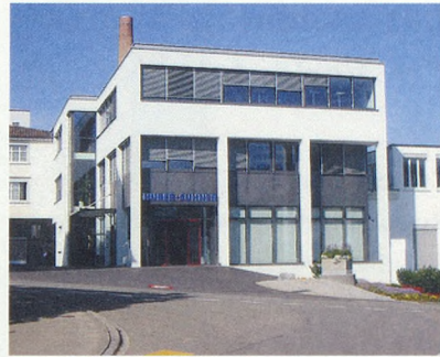
Neues Empfangsgebäude an der Degersheimerstrasse östlich des Gründerhauses.
