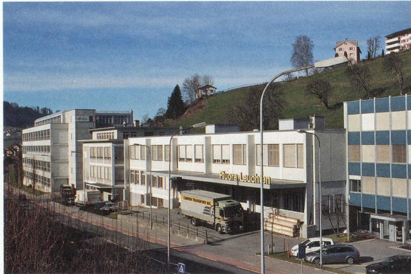
Werkgelände der Fluora Leuchten AG, Herisau (2007). Wie an einer Schnur aufgereiht stehen die Bauten an der St. Gallerstrasse. Beim Gebäude mit dem gelben Fluora-Schriftzug handelt es sich um das erste eigene, 1952/53 erstellte Betriebsgebäude. Es wurde 1968 um ein Stockwerk erhöht.
