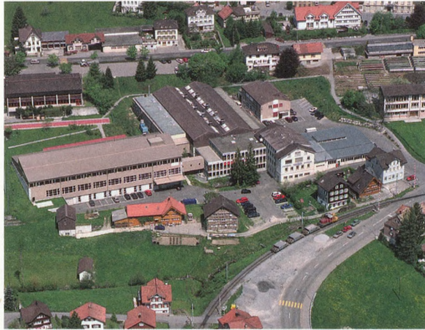
Betriebsgelände der Wagner AG, Waldstatt (2007). Links die 1995 in Betrieb genommene Kunststoff-Spritzgiesserei, gegen hinten die 1981/82 erbaute Aluminium-Druckgiesserei, im Zentrum der Bürotrakt und rechts der Gründerbau von 1949.
