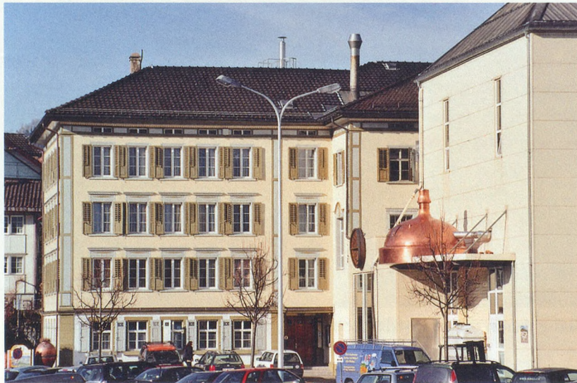
Verwaltungsgebäude der Brauerei Locher AG, Appenzell, erbaut in den Jahren 1862 bis 1864.
