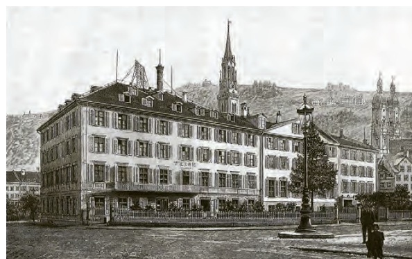
Abb. (49): Das Union-Handelsgebäude mitten in St. Gallen um 1890. Quelle: Hoffman, Huber & Co. (1893), 58.
