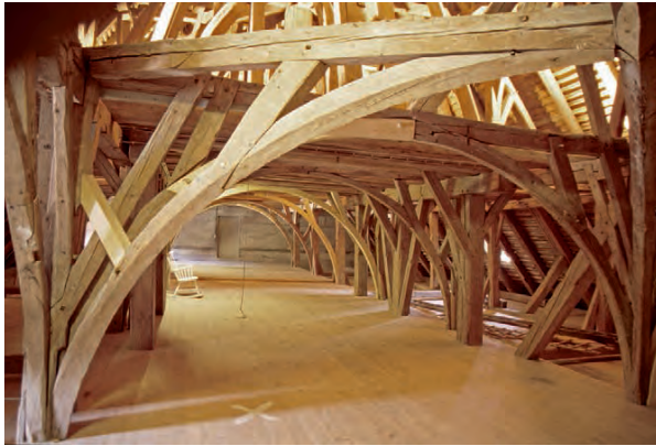
Der Dachstuhl, der die drei alten Flügel der Konventsbauten des Klosters Marienberg in Rorschach überspannt, wurde kurz nach 1500 in berauschender Eleganz errichtet. Die Auswechslung einzelner schadhafter Hölzer ist an deren heller Farbe ersichtlich. Foto: Kantonale Denkmalpflege St. Gallen.
