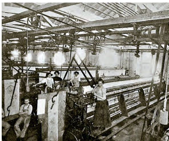
Abb. (43): Maschinensaal der Firma Stickel & Co in den USA. Quelle: LE 1909, 3, 62.
