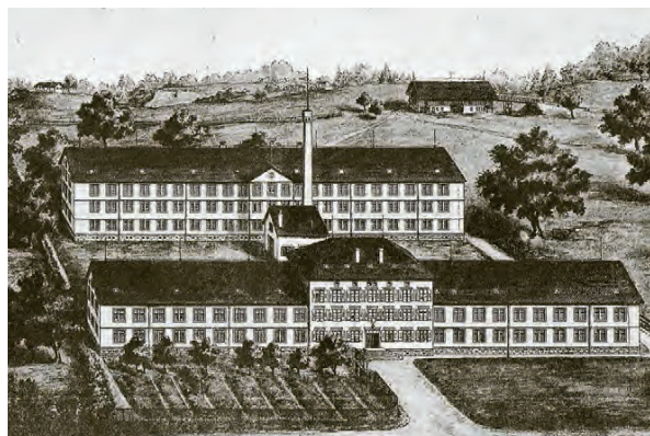
Abb. (40): Die Fabrikgebäude der Handmaschinenstickerei Kronbühl in den 1860er Jahren. Quelle: Hoffman, Huber & Co. (1893), 52.
