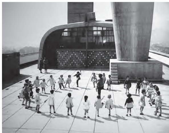
In Marseille konnte Le Corbusier seine Idee der «Unité d'habitation» 1947 erstmals verwirklichen. Der 138 Meter lange, 25 Meter breite und 56 Meter hohe Stahlbetonskelettbau hat eine öffentliche Dachterrasse, die gleichzeitig ein Kinderspielplatz ist. Foto: René Burri, 1958 ( www.writingtoinform.com ).
