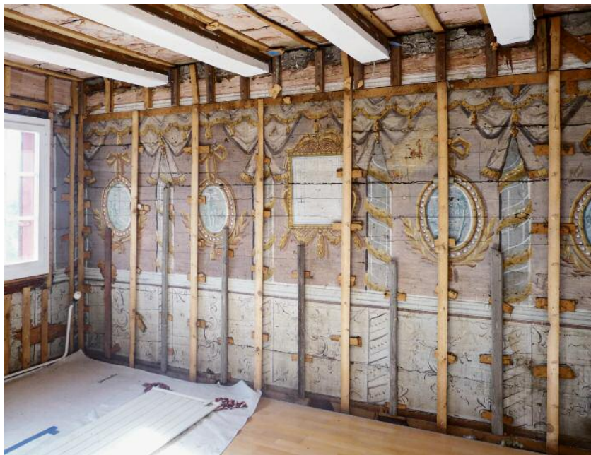
Zustand nach Entfernung der Gipswände.
