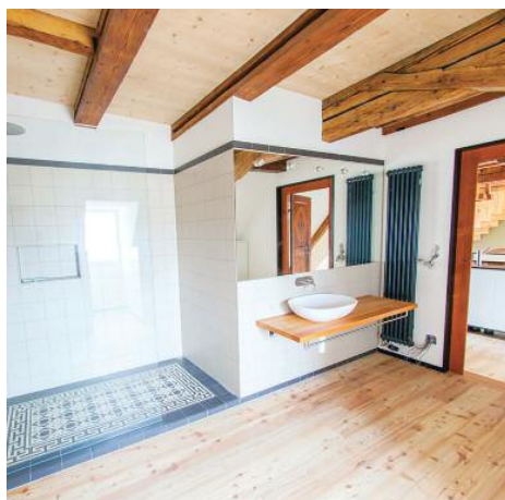
Badezimmereinbau, im Spiegel ist eine wiederverwendete ehemalige Kammertüre zu erkennen. (FM)
