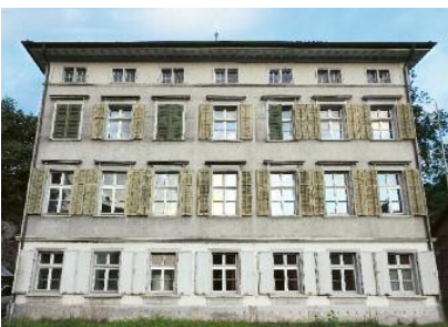
Die Westfassade vor dem Umbau.
