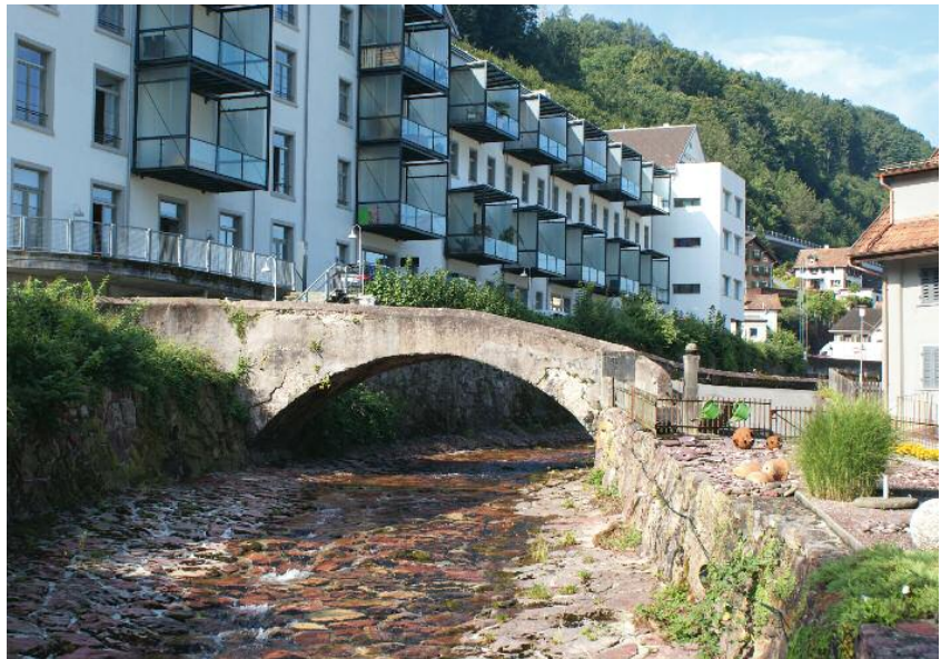
Die Brücke von Westen zu Beginn des 21. Jahrhunderts mit Zementmörtel-Verputz.
