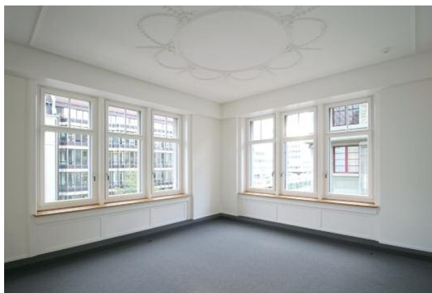
Unter den abgehängten Decken und mit Pavatex verkleideten Brüstungen sind so manche Schönheiten jahrzehntelang verborgen geblieben. Sie können heute, dank grossem Verständnis der Bauherrschaft, wieder bestaunt werden
