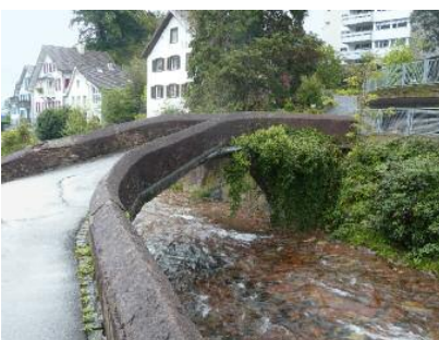
Der breite Einlenker aus Stahlbeton auf der Nordseite.
