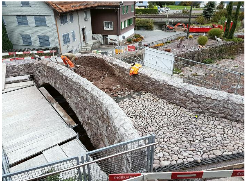
Wiedereinbringen der nur noch teilweise vorhandenen Pflasterung.
