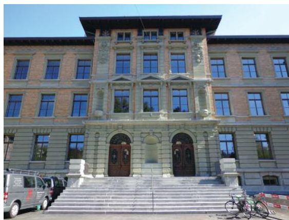
Besonders aufwändig gestaltete sich die Restaurierung der Natursteinelemente der Fassaden. Die Haupttreppe wurde aufgefrischt und das Podest seitlich mit einem Geländer ausgestattet.
