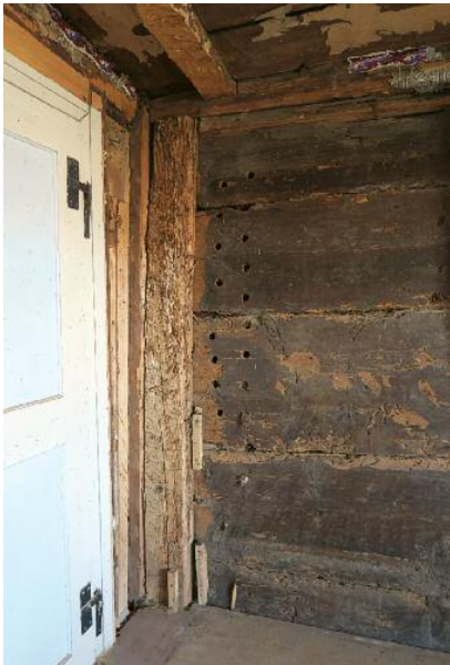
Die Löcher des Zettels in der versetzten Westwand.
