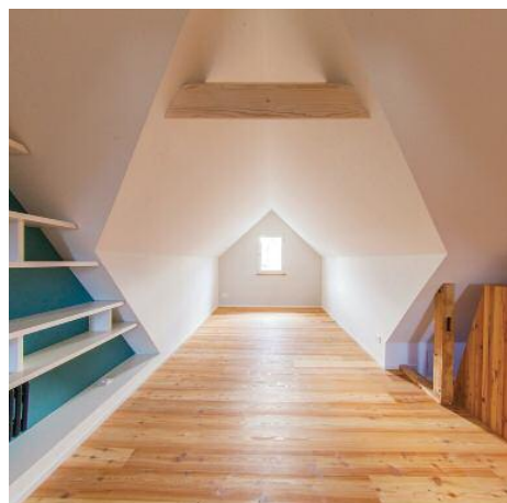
Die beiden Dachkerker (Giebelgauben) sind im zweiten Dachgeschoss nun miteinander verbunden und ermöglichen eine grosszügige Nutzung. (FM)
