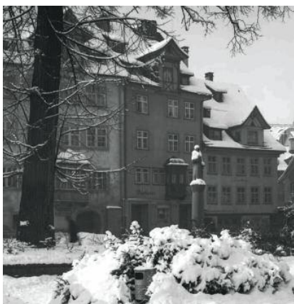
Vor der Renovation 1970 waren die Fassaden verputzt – vor allem im Winter eine willkommene zusätzliche Wärmedämmung.
