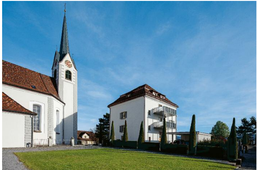
Die geschlossenen Brüstungen der Balkone bilden eine wichtige Zäsur zum Friedhof.
