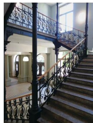
Treppenhaus vor (links) und nach der Sanierung (rechts). Das Treppengeländer wurde nicht nur neu gestrichen, sondern mit einer unauffälligen Erhöhung zumindest teilweise auch an die heute gültigen Normen bezüglich Absturzsicherung angepasst.
