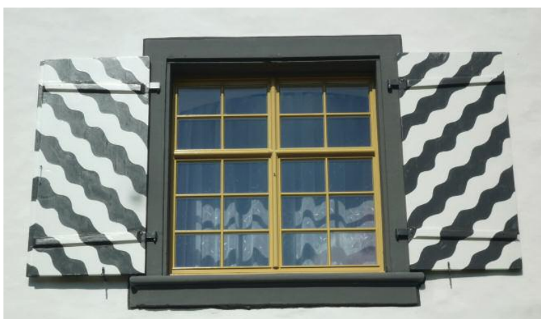
Detailansicht der neu in ockerfarbenem Ton gestrichenen Fenster und mit aufgefrischten Fenstereinfassungen und -läden.
