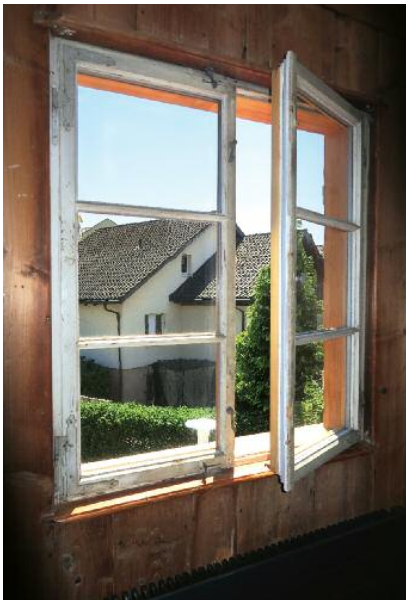
Historisches Fenster mit Isolierglas-Aufdoppelung.
