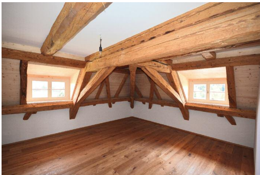
Das ausgebaute Dachgeschoss.
