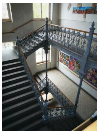
Treppenhaus vor (links) und nach der Sanierung (rechts). Das Treppengeländer wurde nicht nur neu gestrichen, sondern mit einer unauffälligen Erhöhung zumindest teilweise auch an die heute gültigen Normen bezüglich Absturzsicherung angepasst.
