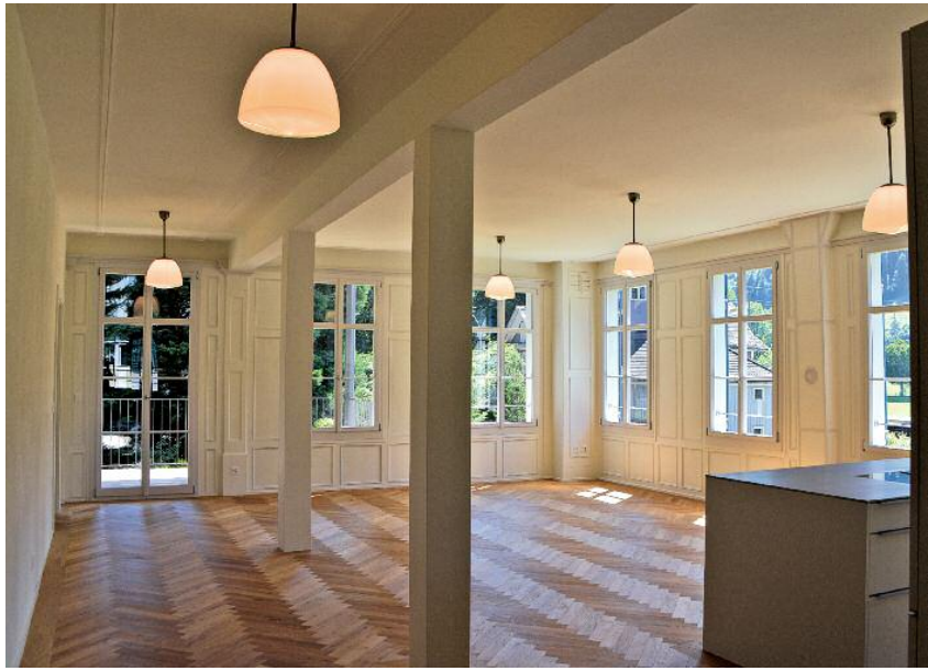
Das ehemalige Schulzimmer im ersten Obergeschoss vor dem Umbau.
