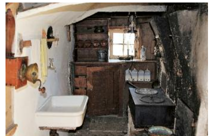
Die historische, verrusste Küche nach der zurückhaltenden Renovation.
