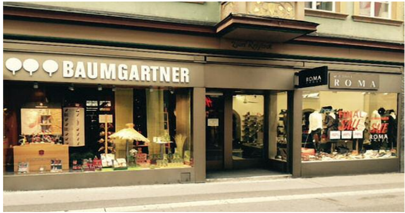
Schaufenstergestaltung von 1979: eloxiertes Aluminium, flächenbündige Rahmenprofile und scharfe Kanten sind symptomatisch für die Spätmoderne. Ein Bezug zur historischen Fassade war dazumal nicht gewollt.
