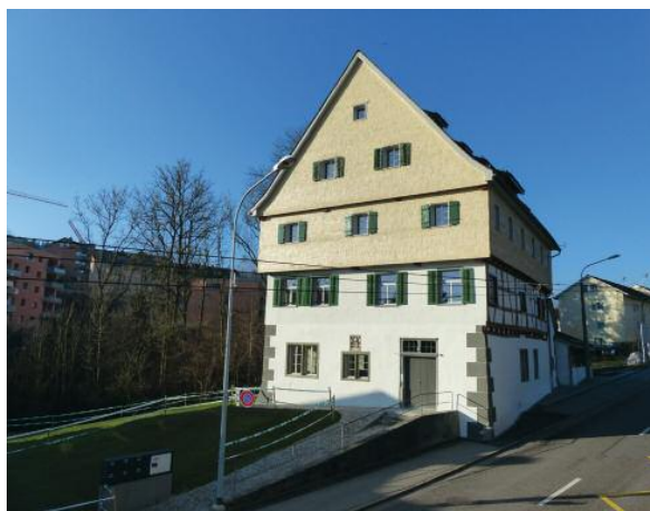
Aufnahme von Nordosten nach dem Umbau (2017).
