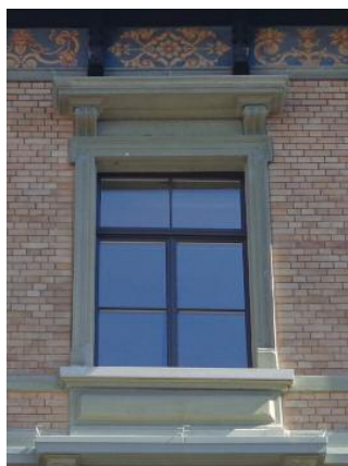
Beim Ersatz der sprossenlosen Fenster aus den 1960er-Jahren wurde das ursprüngliche Erscheinungsbild angestrebt.
