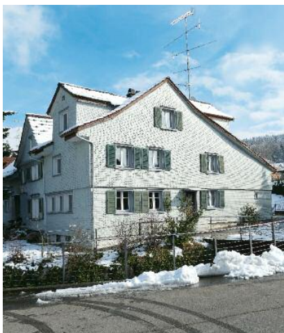
Ansicht von Nordwesten im Eternit-Kleid vor der Renovation.
