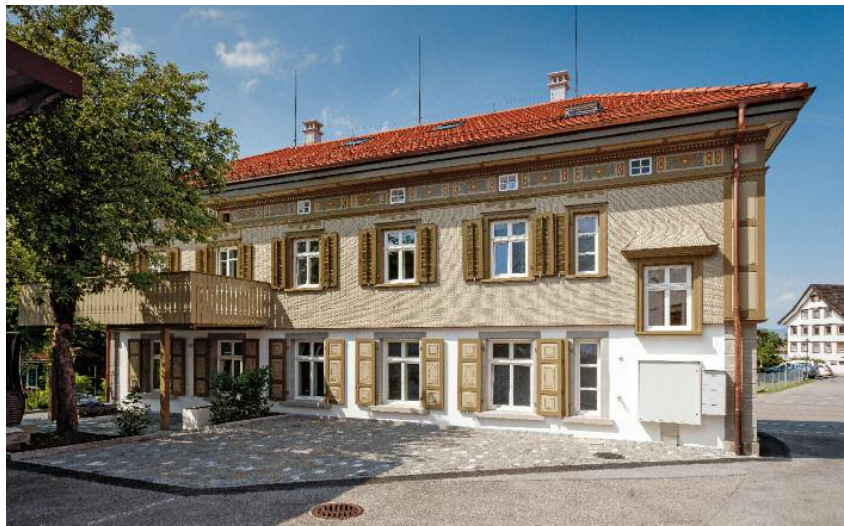
Die renovierte Rückfassade mit dem rekonstruierten Balkon; im Erdgeschoss die neu bemalten Fensterläden.
