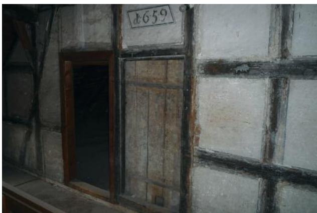
Im zweiten Dachgeschoss ist noch viel von der originalen Substanz sichtbar und verleiht einen Eindruck, wie es vor 400 Jahren im Haus ausgesehen haben könnte.
