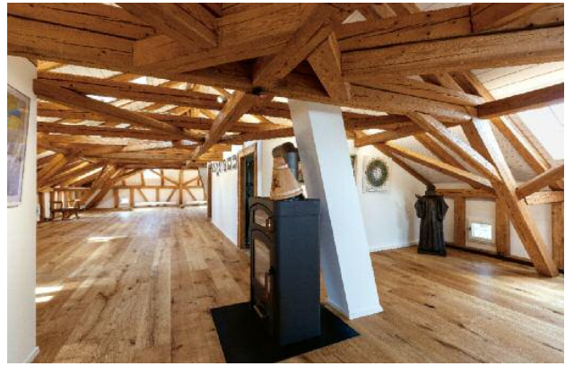
Der grosszügige, aber niedrige Dachboden mit dem traditionell abgezimmerten Dachstuhl wird zum Ausstellungsraum.
