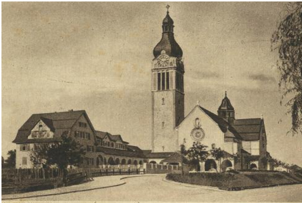
Historische Aufnahme von 1919, kurz nach der Bauvollendung. Die monumentale Erscheinung ist nicht nur Zeugnis einer hervorragenden architektonischen Leistung, sie widerspiegelt auch die Frömmigkeit, den religiösen Eifer und das Marienbild der Erbauer.
