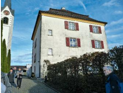
Ansicht von Westen vor dem Umbau. Foto Kantonale Denkmalpflege.
