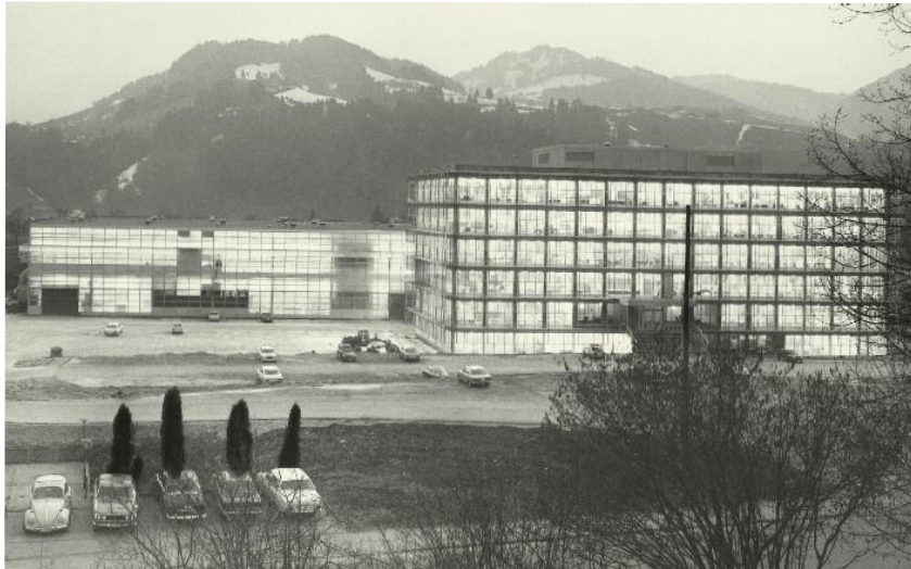
Bürobau und Fabrikhalle Heberlein & Co., Wattwil, erbaut 1969/70 von Walter Custer, Fred Hochstrasser und Hans Bleiker. Foto um 1970, Staatsarchiv St.Gallen.
