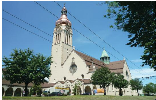
Bei der Fassadenrenovation stellten weniger die restauratorischen Massnahmen als vielmehr die gewaltigen Ausmasse eine Herausforderung dar. Die originalen Farben und Muster konnten aufgrund der guten Befunde weitgehend rekonstruiert werden, so dass sich die Kirche heute wieder wie vor 100 Jahren präsentiert.
