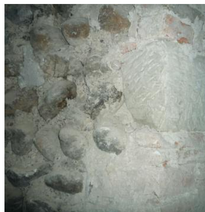
Im Erdgeschoss fügen sich Mauerreste aus verschiedenen Jahrhunderten zusammen. Die teilweise russgeschwärzten und versengten Bollensteine lassen eine Bauzeit vor dem grossen Stadtbrand 1418 vermuten.
