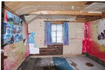
Dachkammer vor der Renovation 2011.
