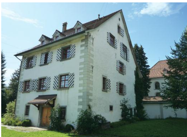
Zustand vor der Renovation (2016) mit ausgebleichten und verschmutzten Fassaden und roten Fenstern.
