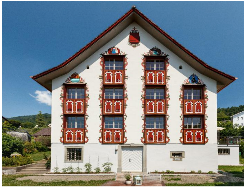
Das Pfarrhaus nach der Renovation.
