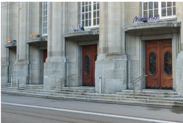
Dank hochwertiger Ausführung und der technischen Aufrüstung konnten die originalen Türen und Fenster restauriert und erhalten werden.
