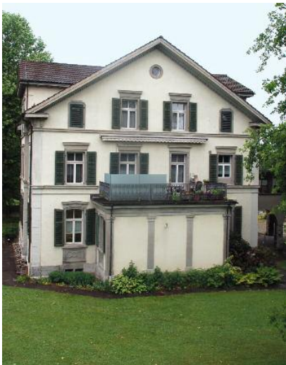
Die Ostfassade 2015 vor der Renovation.
