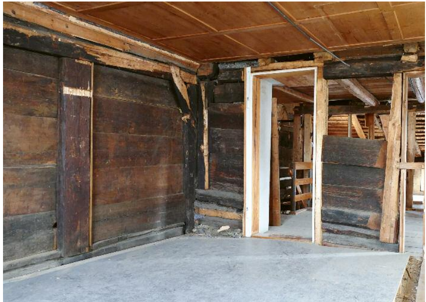
Stubenkammer des Hauses 4a, Blick gegen Südosten, links die Aussenwand des Kernbaus mit einer späteren Türöffnung.
