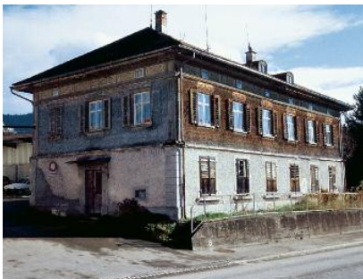
Verwitterter Zustand im Jahr 2007. Foto: Kantonale Denkmalpflege.
