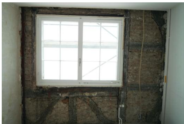
Unter einer Spanplattenverkleidung verborgen, aber nicht genügend geschützt, noch stellenweise originale Bausubstanz erhalten, hier auf der Hofseite, wo sich früher wohl ein Schlafgemach befand.
