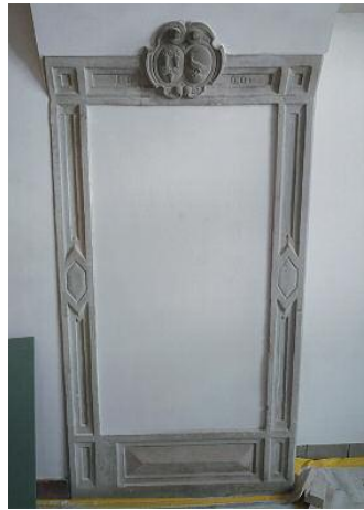
Wiederendeckte Sandstein-Rahmung, vermutlich eines Schrankes oder eines Tresors. Die Inschrift „1666“ deutet wohl auf einen Umbau hin.
