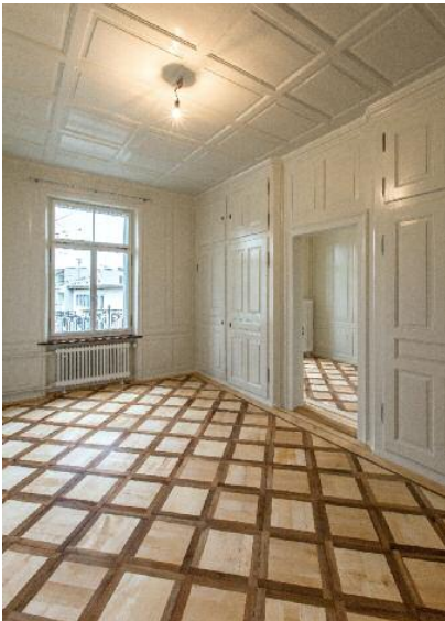
Zimmer im Obergeschoss mit Parkettboden, Wand- und Deckentäfer aus der Bauzeit.
