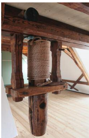
Der intakt erhaltene „Bürdeli-Aufzug“ wurde sorgfältig restauriert. (FM)
