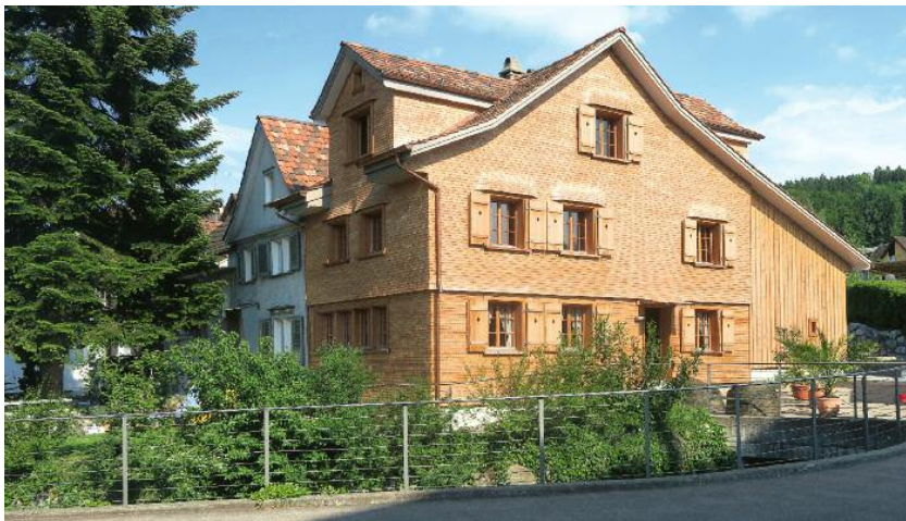
Dieselbe Ansicht nach der Renovation mit neuen Holzschindeln und dem leicht abgesetzten Anbau.
