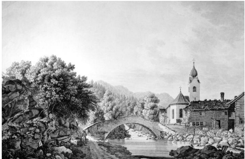
Der Kupferstich von Achilles Benz aus dem Ende des 18. Jahrhunderts zeigt die Brücke von Osten und dahinter die 1976 abgebrochene barocke Kirche.
