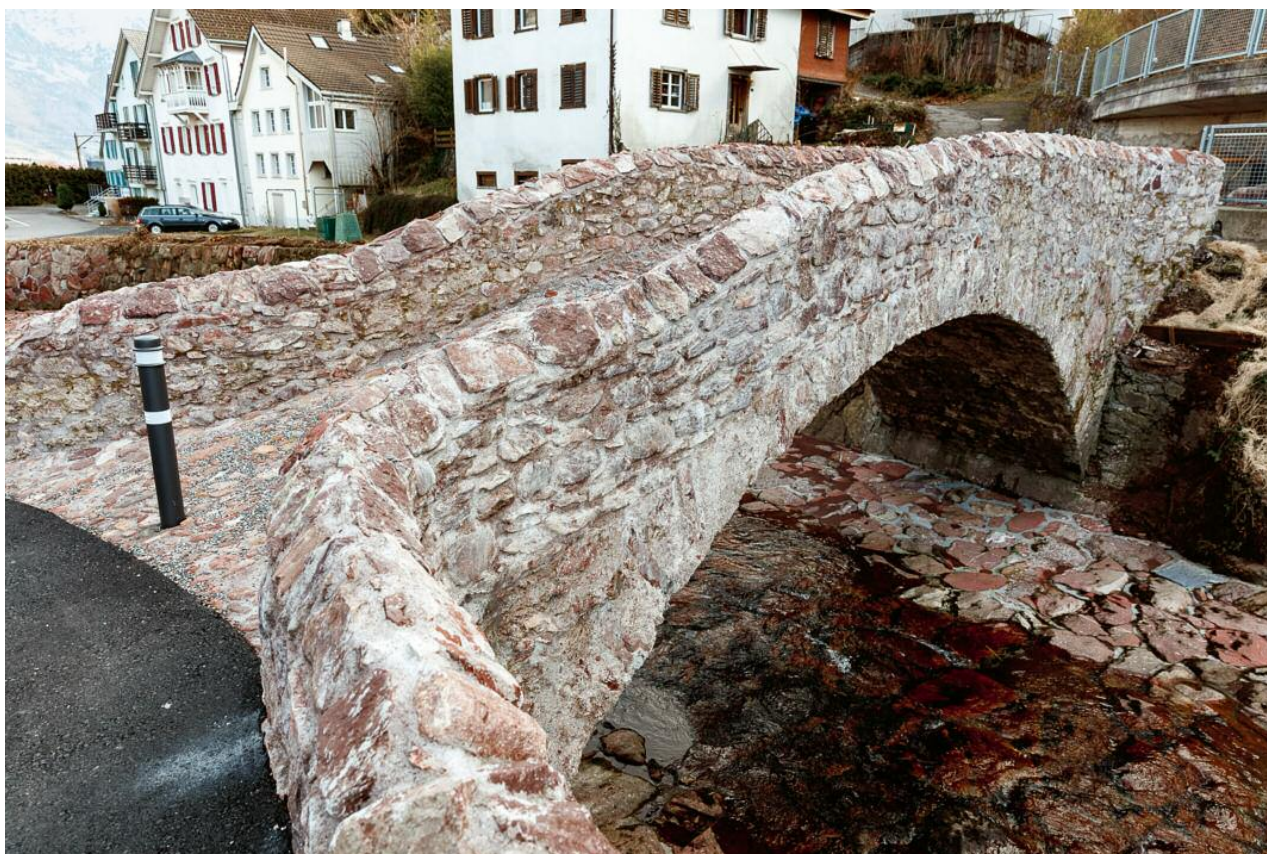
Die restaurierte Brücke mit zurückgebautem Einlenker und von Zement befreiten Begleitmauern.
