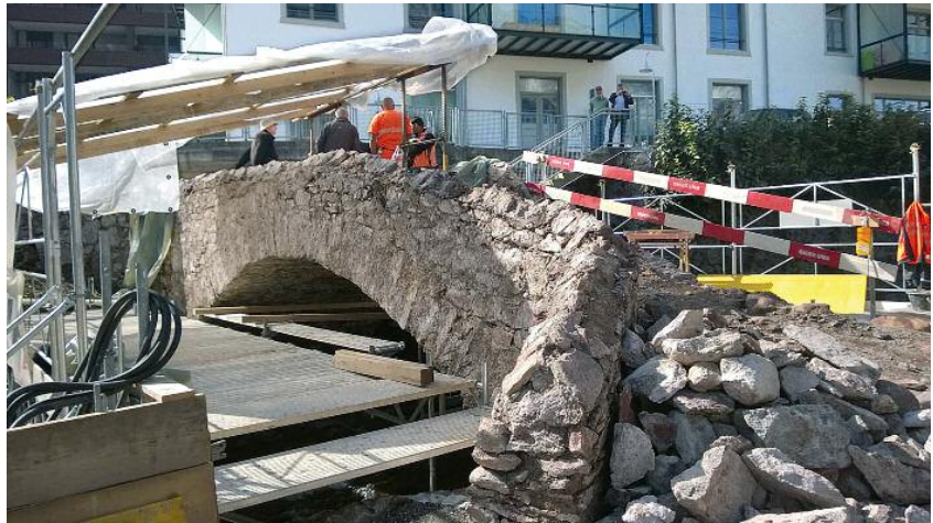
Sorgfältige Reparatur unter grösstmöglichem Erhalt der gesunden Brückenteile.
