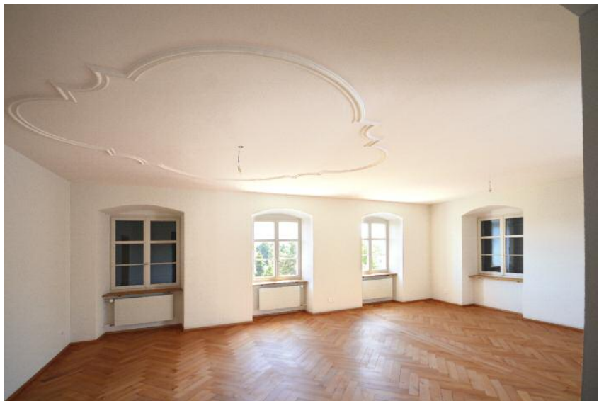
An der Stuckdecke kann die frühere Wandeinteilung abgelesen werden.
