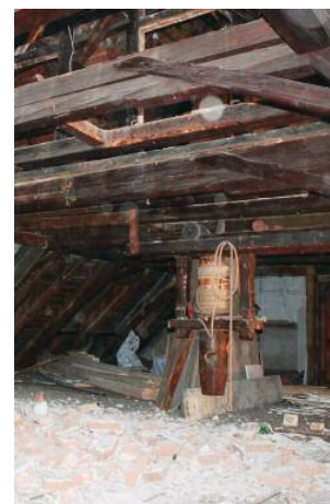
Rückbau der bestehenden Einbauten bis auf das Grundgerüst. (FM)
