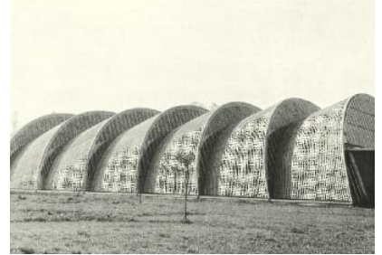
Die Gummibandweberei von Osten her. Die schräggestellten Betonschalen überbrücken den Fabriksaal stützenfrei.
