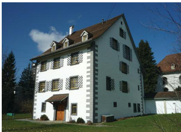
Zustand nach der Renovation (2017) mit frisch gekalktem Putz, aufgefrischten Ecklisenen und den neuen Fenstern.
