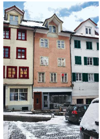
Fassade zur Kirchgasse vor der Renovation.
