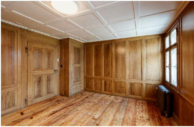
Das mittlere Zimmer im Obergeschoss mit der originalen, mit ihren kleinen Gebrauchsspuren belassenen Maserierung.
