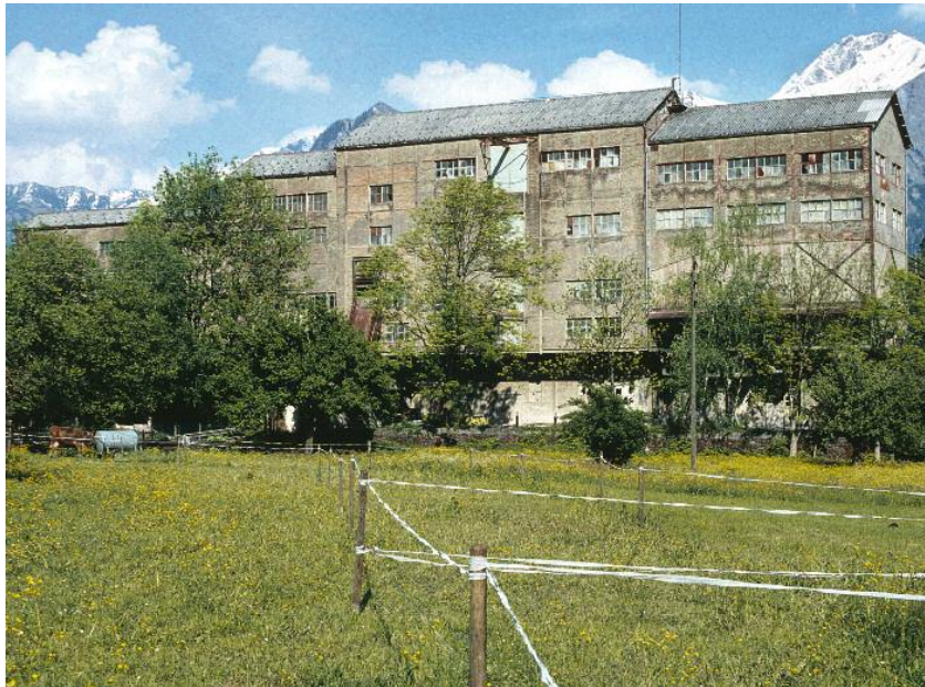
Aufbereitungsanlage Malerva, Sargans. Hier wurde das Eisenerz aus dem Gonzen gebrochen, klassifiziert und sortiert direkt auf Eisenbahnwagen verladen. Foto: Kantonale Denkmalpflege 2005.
