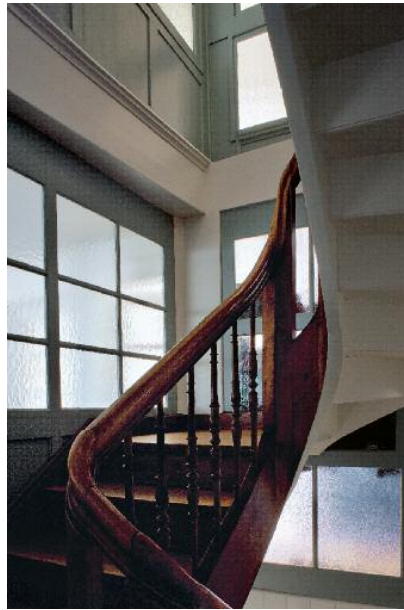
Trotz Brandschutz konnten die alten Treppenhausverglasungen erhalten werden.
