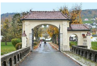
Das Haupt-Zufahrtstor mit der kleinen Allee von der Töberstrasse her. Foto Kantonale Denkmalpflege.
