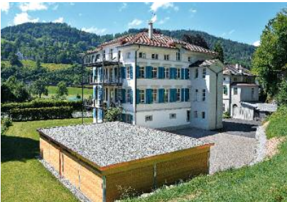
Ansicht von Südosten nach der Renovation.
