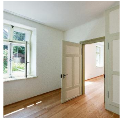
Der einfachere Ausbau im Erdgeschoss.
