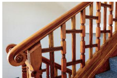
Treppenhaus mit renoviertem Geländer.
