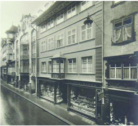
Fassade um 1903, als man noch von Kolonialwaren und nicht von Retail sprach. Charakteristische Elemente wie die grossen Glasflächen, gebogene Scheiben oder profilierte Stützen wurden in die neue Gestaltung übernommen.
