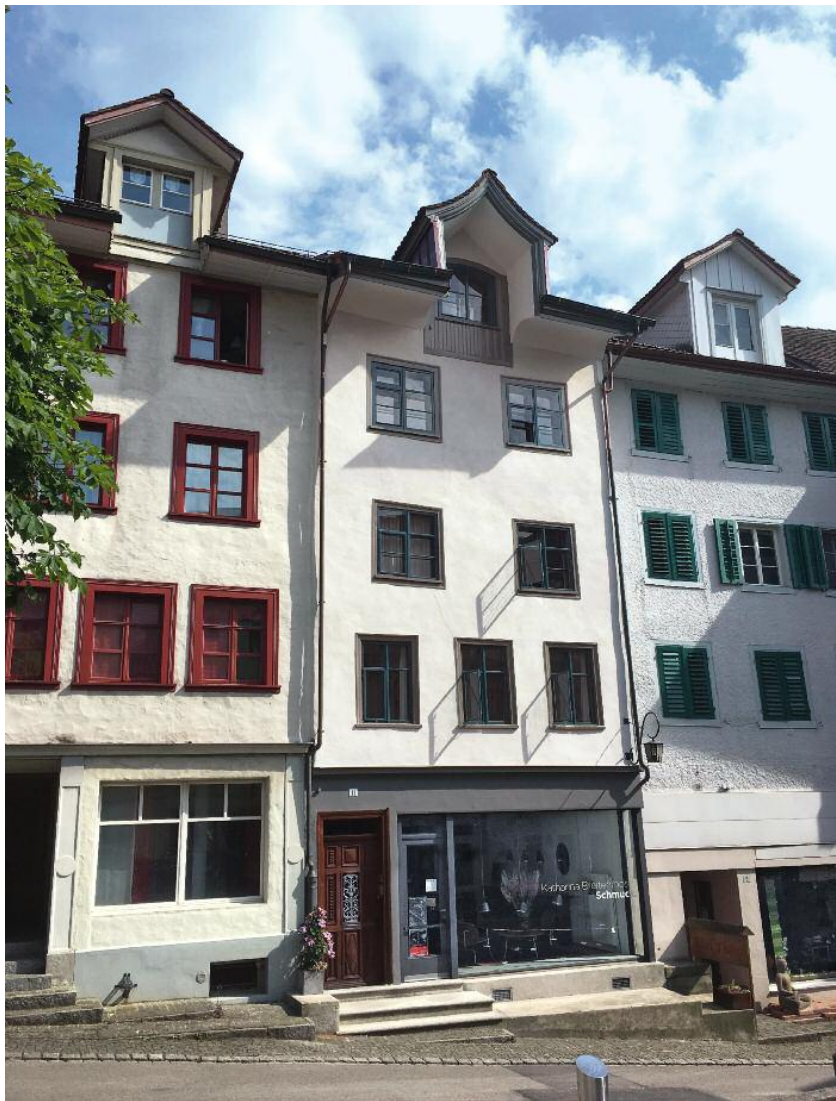
Die renovierte Fassade zur Kirchgasse.
