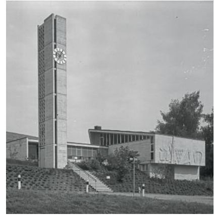
Das evang. Kirchgemeindehaus Winkel, erbaut 1962 nach Plänen von Max Künzler, mit einem Betonrelief von Werner Weiskönig an der Fassade.
