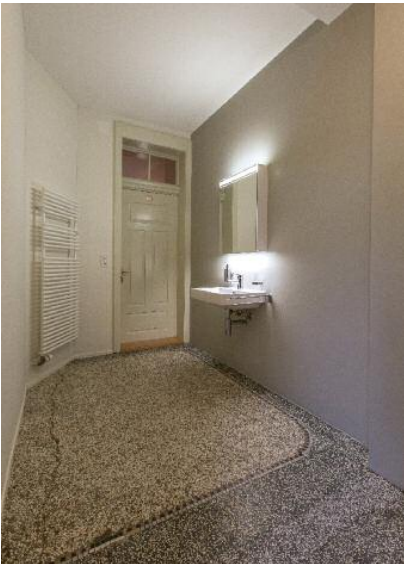
Bad im Obergeschoss mit hervorgeholtem Terrazzoboden.
