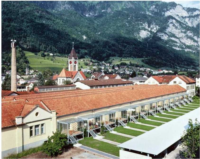
Weberei Walenstadt, ein Bau von 1861. Durch atelier-f architekten, Fläsch, wurden 1998–2000 Lofts und das Museum Bickel eingebaut. Foto: atelier-f architekten, Fläsch.
