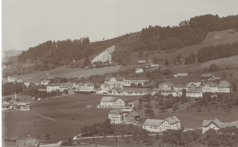
Abb. 4: Südwestansicht Bühler mit Langebäu, nach 1889
