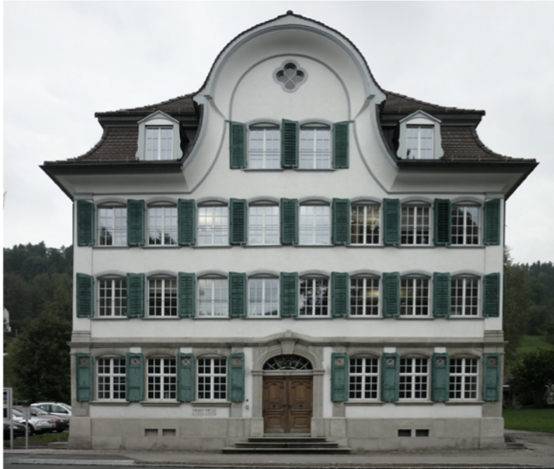
Abb. 22: Türmlihaus, Südfassade, erbaut um 1790
