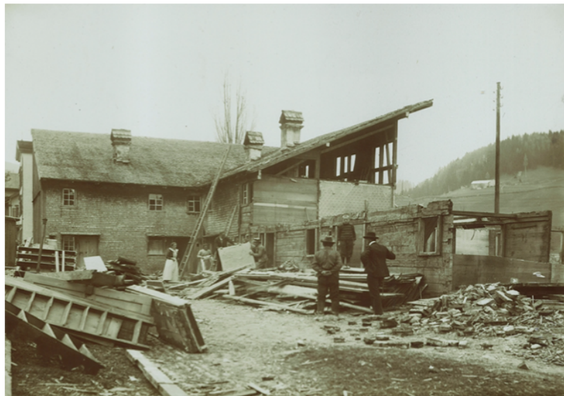
Abb. 13: Abbruch (2) des letzten Langgebäu, Rückseite, nach Osten Blickend, um 1909
