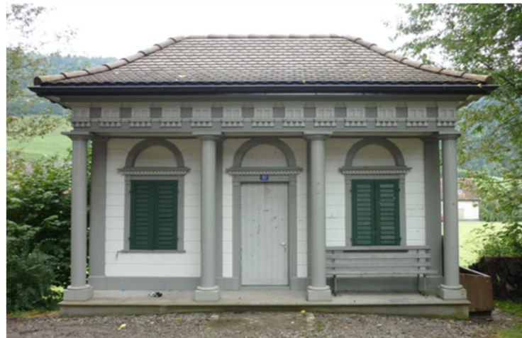
Abb. 26: Gartenhaus, Fassade zum Türmlihaus (Nordfassade) vor 1817 oder um 1828
