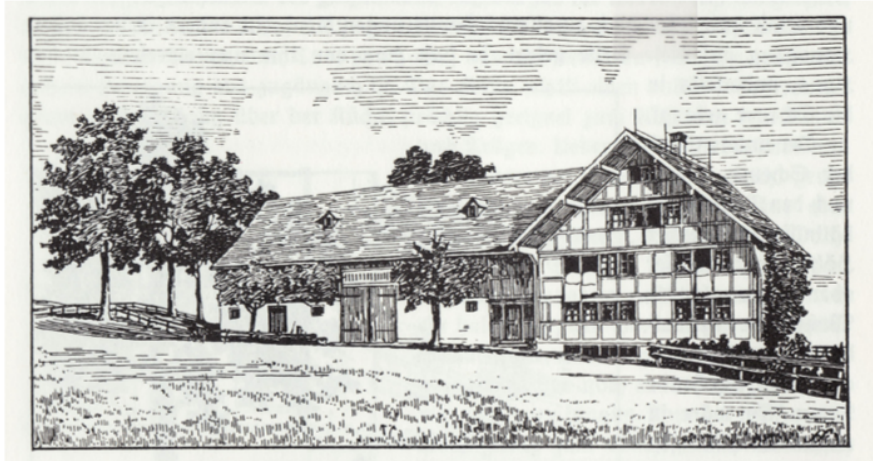
Abb. 19: Fassade eines grösseren Hauses mit Schönnenanbau
