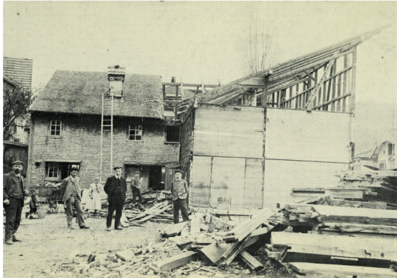
Abb.12 : Abbruch (1) des letzten Langgebäu, Rückseite, Ostflügel, um 1909
